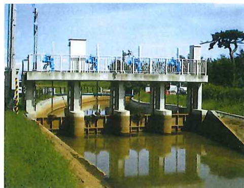
砂山調整ゲート整備後
