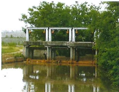
砂山調整ゲート整備前
