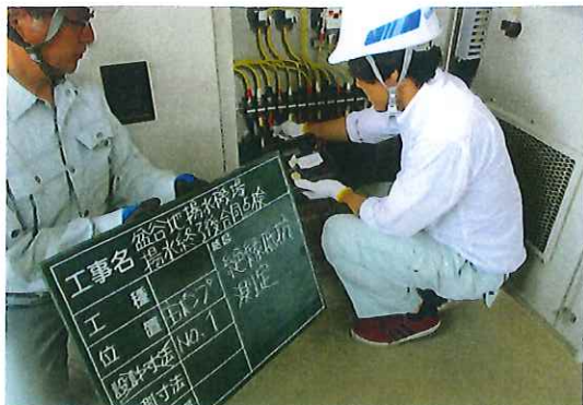
盆谷地揚水機場絶縁抵抗測定
