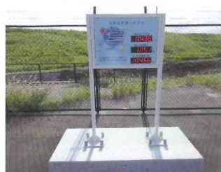
発電量モニター
