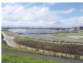
太陽光発電施設
