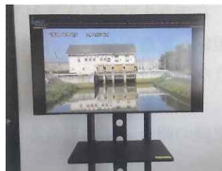
監視カメラ画像（高砂南部排水機場）
