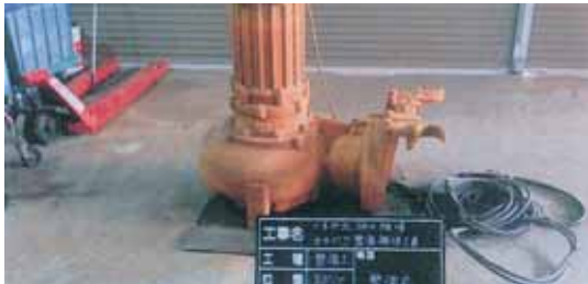
整備前（ポンプ引き上げ）
